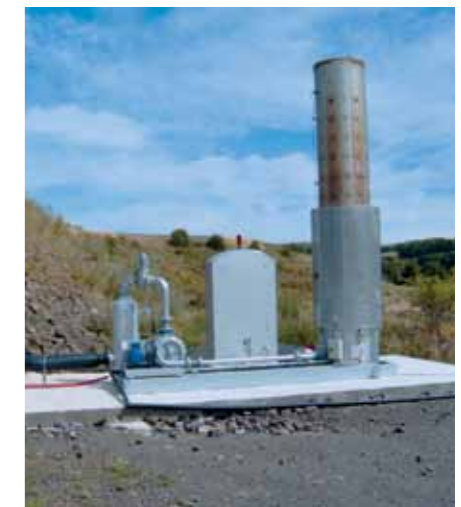
Torchère en service pour brûler le biogaz et limiter les odeurs
